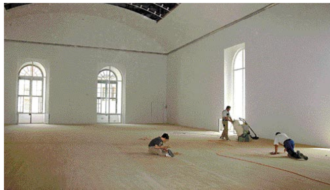
Im West- und Südflügel des Schloss Neuburg wurde neues Stabparkett verlegt.
